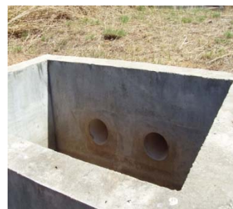
Lançamento de águas pluviais em corpo hídrico
