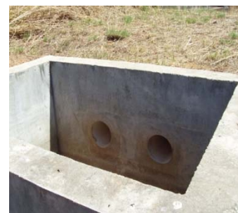
Lançamento de águas pluviais em corpo hídrico
