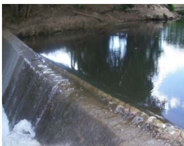
Obras de barramento
